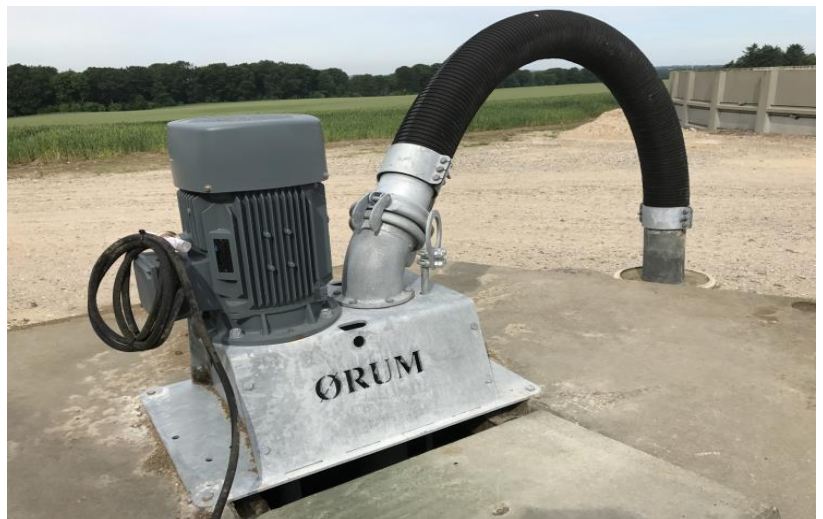
Montiert mit Schlauch und Schlauchanschluss (Option)
